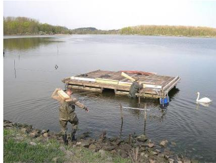
Zuerst wurden die Rohre in mit Beton gefüllten Eimern gestellt. Diese werden nach dem Aushärten in den Grund des Binnenwassers mit Hilfe eines Tauchers eingeschwemmt.
